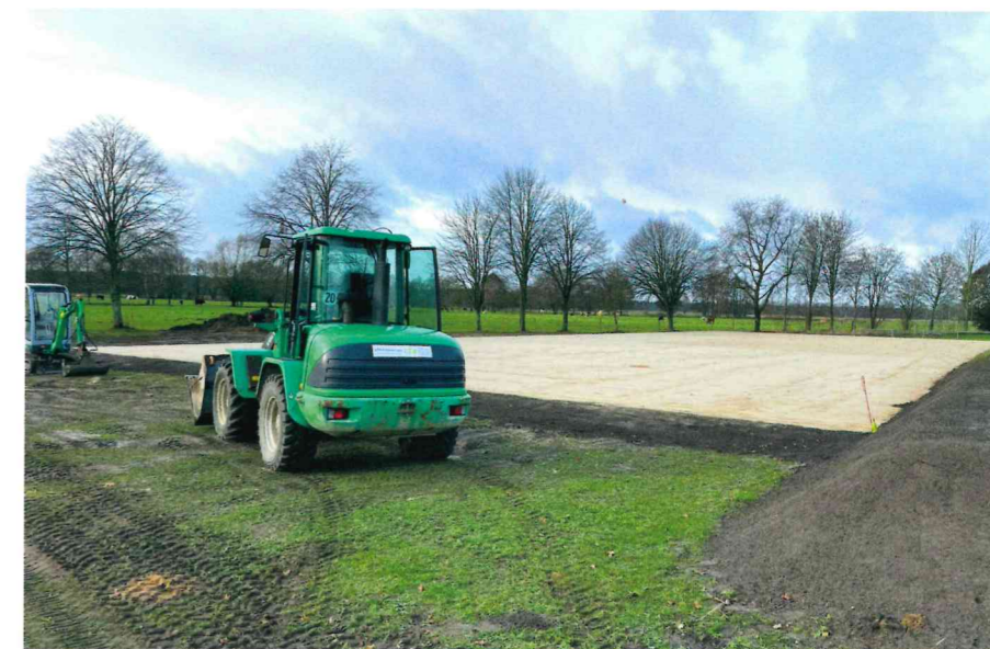
Lasergesteuerte Planierarbeiten der Firma LTB sorgen dafür, dass Sport- und Reitplätze, Gewerbehöfe und Grundplatten perfekt plan sind.
